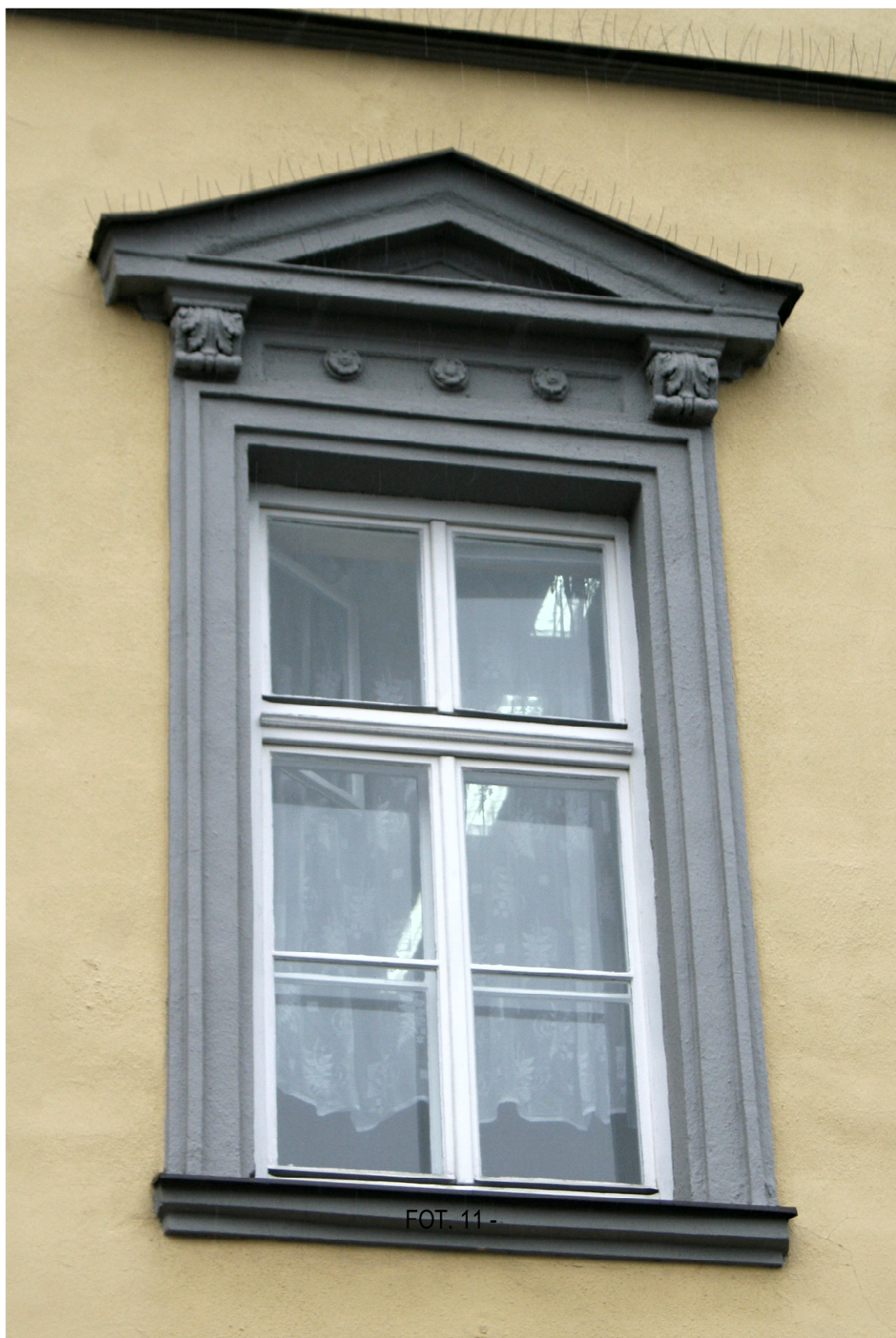
FOT. 11 - DEKORACJA SZTUKATORSKA OKNA NA POZIOMIE I PIĘTRA - ORYGINALNY NACZÓŁEJK TRÓJKĄTNY
